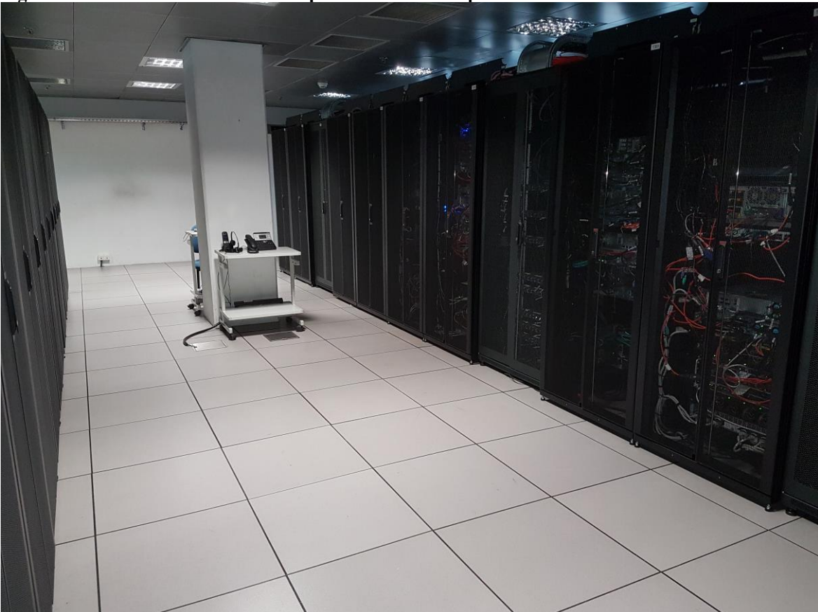
Figure 4 : Couloir de baies climatisées par un circuit d'air provenant du sous-sol
