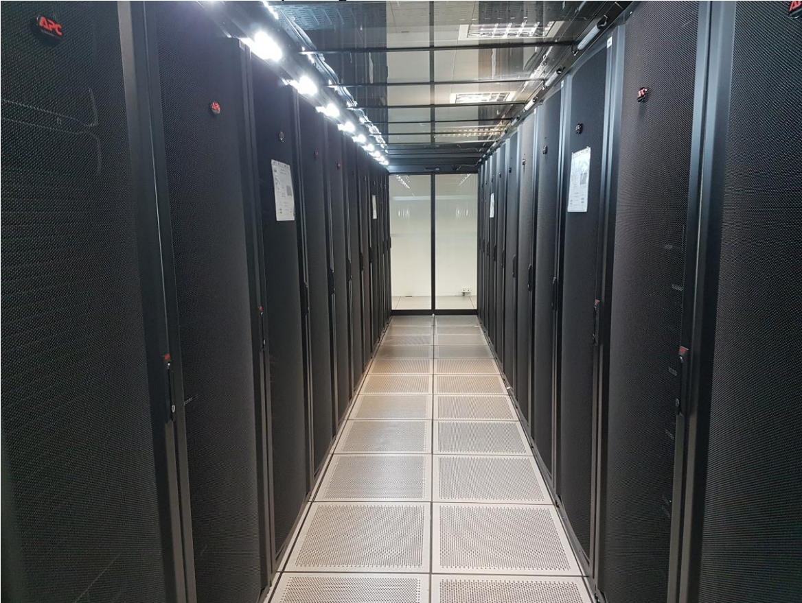
Figure 4 : Couloir de baies climatisées par un circuit d'air provenant du sous-sol
