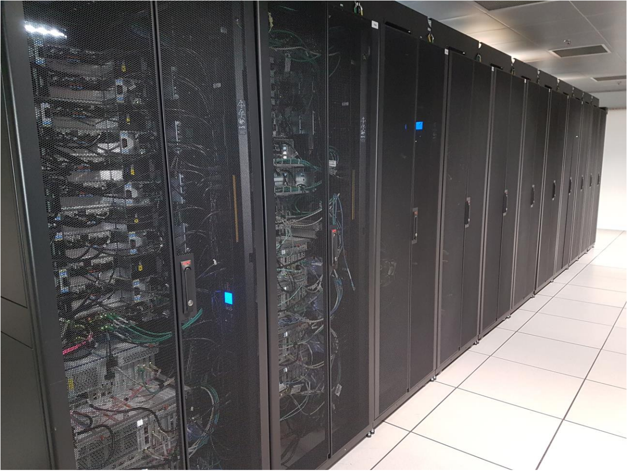
Figure 5 et 6 : Couloir non climatisé
